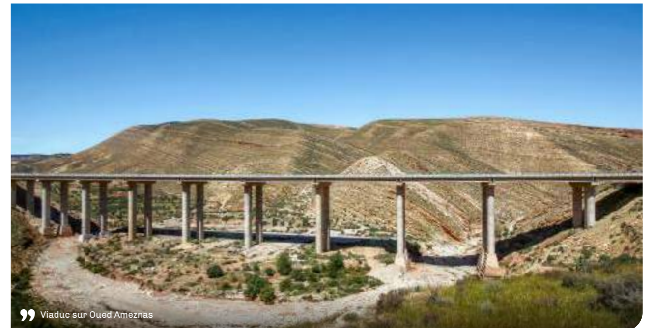
Viaduc sur Oued Amezri
